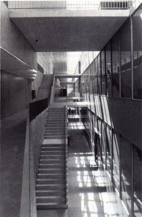
Die Kaskadentreppen im Raumschlitz. Links der Serviceblock aus Beton, rechts der Klassentrakt
