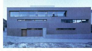
Seitenfassade mit Hintereingang und Garagenabfahrt. Der umgebende Bodenbelag entspricht formal der Zyklopenfassade, ist aber an Ort gegossen worden
