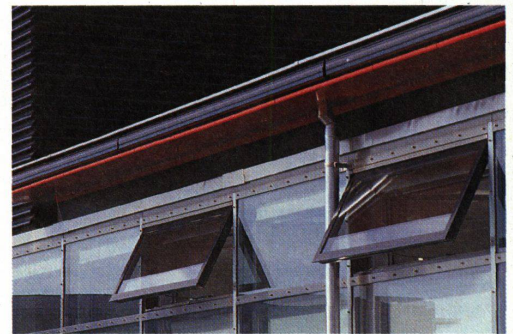
Punkt 2: Die Angestellten öffnen die Kippfenster, um nachts die Betondecke zu kühlen
