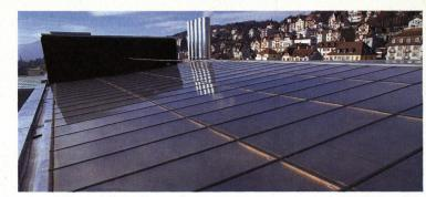
Punkt 6: 1200 Quadratmeter Heizwasserkollektoren befinden sich auf dem Dach
