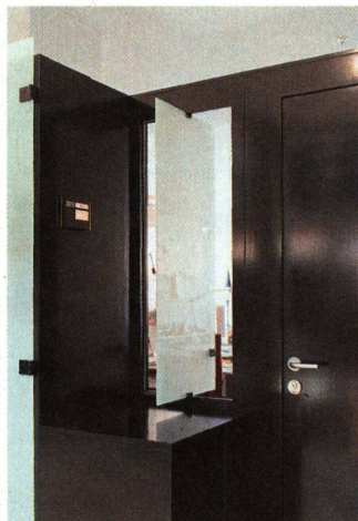
Punkt 3 + 5: Die Lüftungstürchen zwischen Gang und Büros bringen frische Luft
