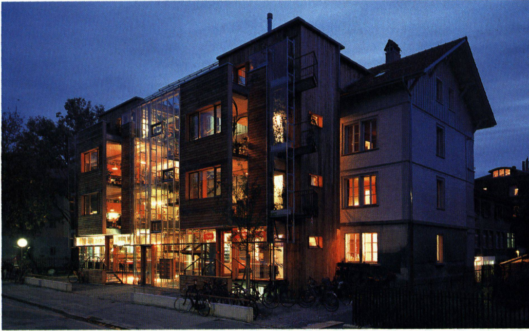
Die zwei neuen Türme auf der Strassenseite des Hauses mit Küchen, Toiletten und den «Nouvel-Balkonen». Im Erdgeschoss das Café Kairo und der Waschsalon «Jet-Wash»
