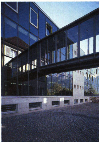
Die Fassadenelemente bestehen aus beschichtetem Isolationsglas, dazwischen Gummi. Die Fensterflügel sind aus Aluminium
