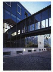
Die Fassadenelemente bestehen aus beschichtetem Isolationsglas, dazwischen Gummi. Die Fensterflügel sind aus Aluminium
