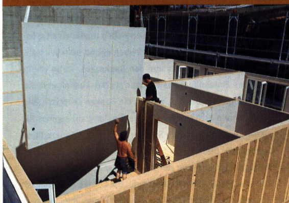
Montage der Innenwände
