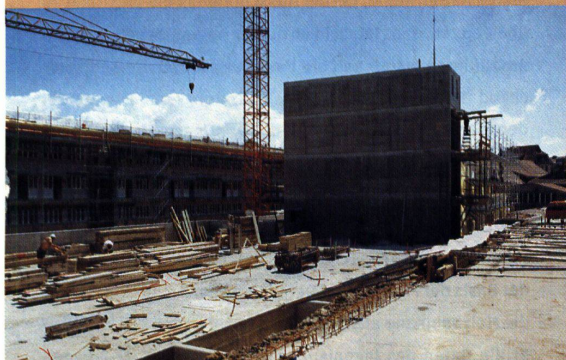
Das Betonfundament der zweiten Zeile mit dem Treppenhaus, ebenfalls aus Beton. Im Hintergrund die schon aufgerichtete erste Zeile
