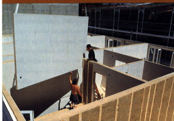
Montage der Innenwände
