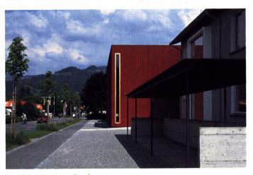
Die Schalung besteht aus sägerohem Fichtenholz, denn die benötigte Brettlänge in guter Qualität ist nur in Fichte erhältlich. Die Fensterrahmen, die Säulen und der Boden sind aus naturbelassener Eiche
