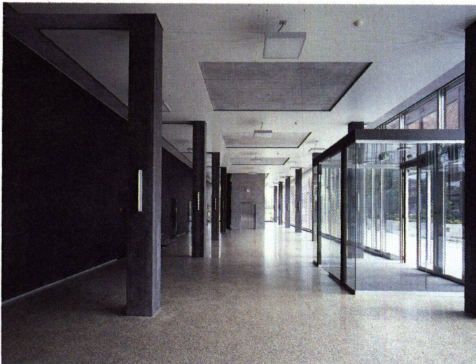
Das Foyergebäude mit innenliegenden Stützen. Links die Wände zu den Hörsälen mit Schieferplatten verkleidet
