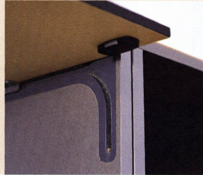
Ein gut gelöstes Detail: eingelassen statt aufgebracht, die Führungsschiene für die Klapptüre
