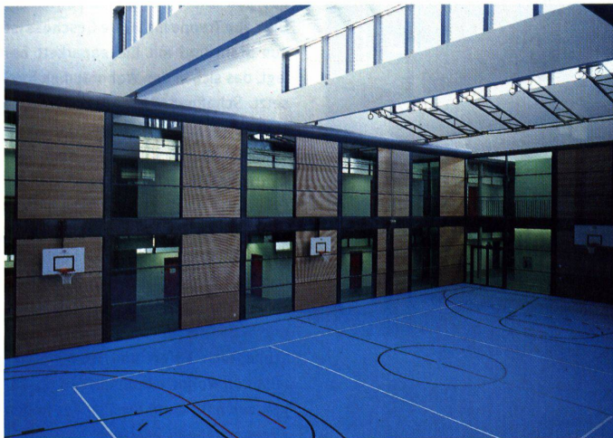
Die Turnhalle mit der Belichtung über die Sheddächer
