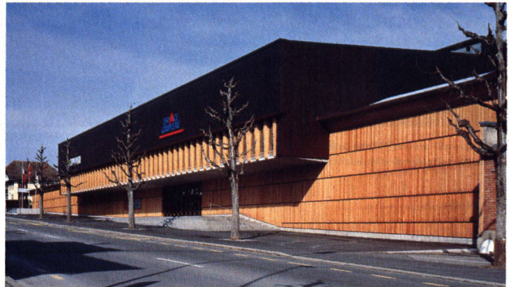
Auf der Strassenseite kragt der verglaste Restorantriegel über den Eingang heraus
