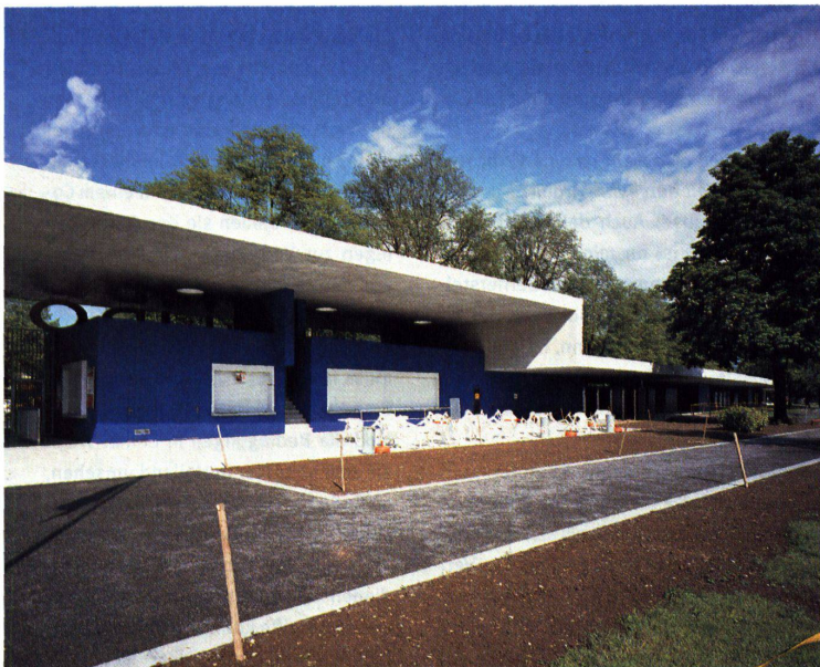
Das grosse Dach, eine monolithische Ortsbetonplatte, bindet die darunter gestellten Elemente zusammen
