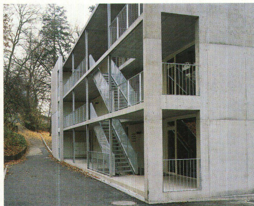
Breite Laubengänge an der Ostfassa- de. Die Nordfassade ist Betonwand
