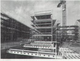
Die Erweiterung der Gewerbeschule im Bau: ein viergeschossiger ungeschützter Stahlbau F 30
