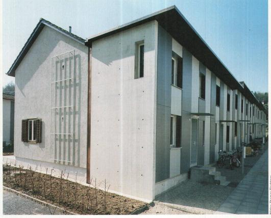
Altbau und Erweiterungsschicht werden als Ganzes behandelt – Schweissnaht ist die offene Dachrinne
