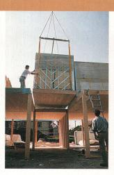
Ölzbündt im Bau: Die Montage eines Deckenelements mit im Werk aufgebauter Nasszelle (links) Ständerkonstruktion mit vorproduzierten vorgehängten Wandelementen (unten)
