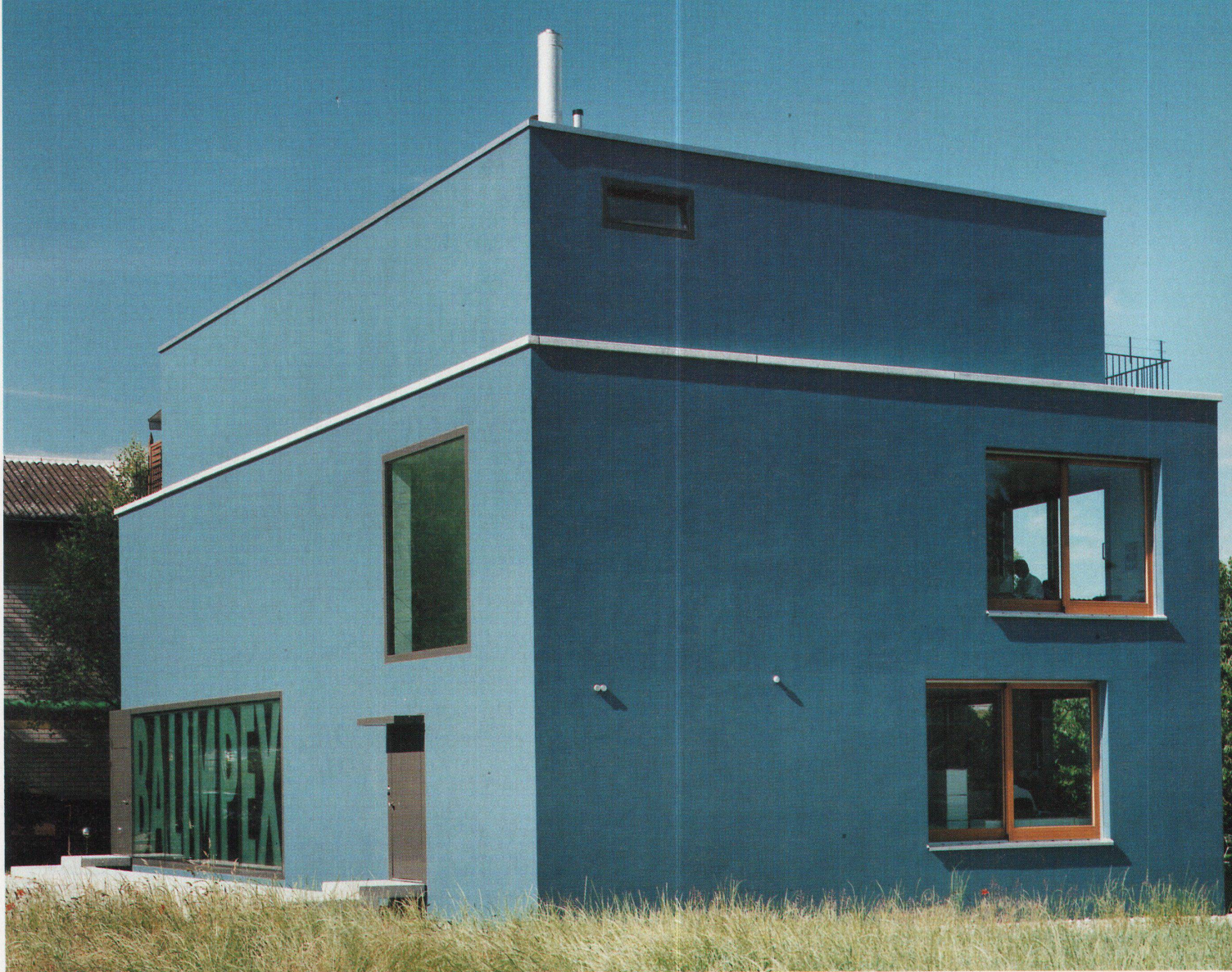
Scharf, glatt, karg, tiefblau. Das Gebäude präsentiert sich als unbestimmbares Objekt
