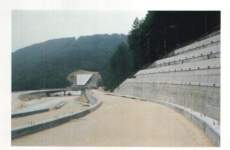
Portale und Lüftungszentrale Mont Russelin Nord bilden eine Einheit. Eine gerippte Betonscheibe duckt sich flach an den Hang und deckt die Zentrale unter sich zu
