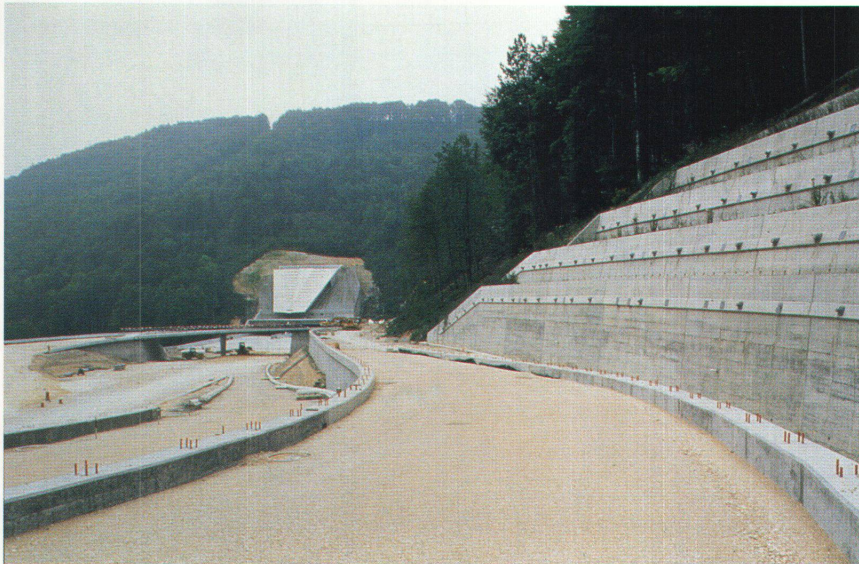
Portale und Lüftungszentrale Mont Russelin Nord bilden eine Einheit. Eine gerippte Betonscheibe duckt sich flach an den Hang und deckt die Zentrale unter sich zu
