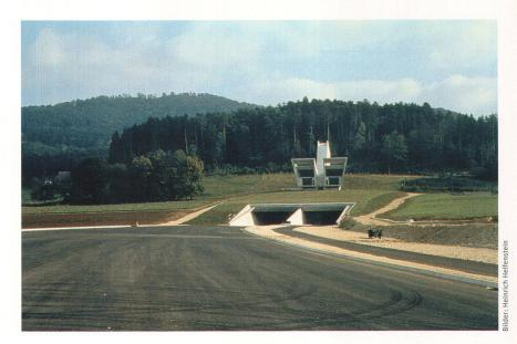
Lüftungszentrale und Tunnelportale Mont Russelin Süd. Die beiden Ansaugstutzen und der dazwischen liegende Kamin der Filteranlage werden zu autonomen Figuren in der Landschaft
