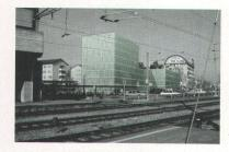
Mit einer der Fassade vorgelagerten Verglasung fassen Bünzli Courvoisier Roserens die verschiedenen Raumfunktionen zu einem Solitär zusammen. Hinter der gleichmässigen Einfachverglasung liegen die unterschiedlich grossen Fensteröffnungen der Verwaltungsund Gefängnistrakte. Über schmale Kasten, die die Verglasung durchstossen, kann das Gebäude direkt belüftet werden
