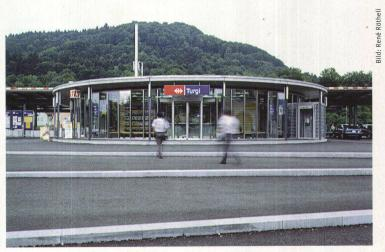
Turgi: Der Zylinder besteht aus einem Dach auf vier zentralen Pfeilern, das Vordach liegt auf sechzehn schmalen peripheren Stützen. Eine transparente Fassade trennt den Innenvom Aussenraum.
