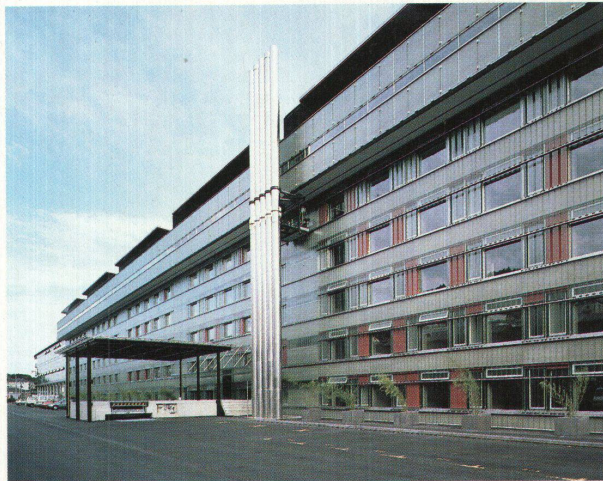
Die Gerade. Unten die fünf Büroggeschosse mit der Profilfassade, darüber die Auskragung des Dachgeschosses
