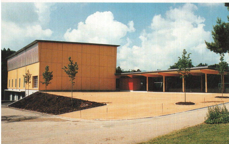
Die Elemente der Turnhalle waren innerhalb von vier Tagen auf dem Fundament montiert, jene des Annexbaus in zwei Tagen
