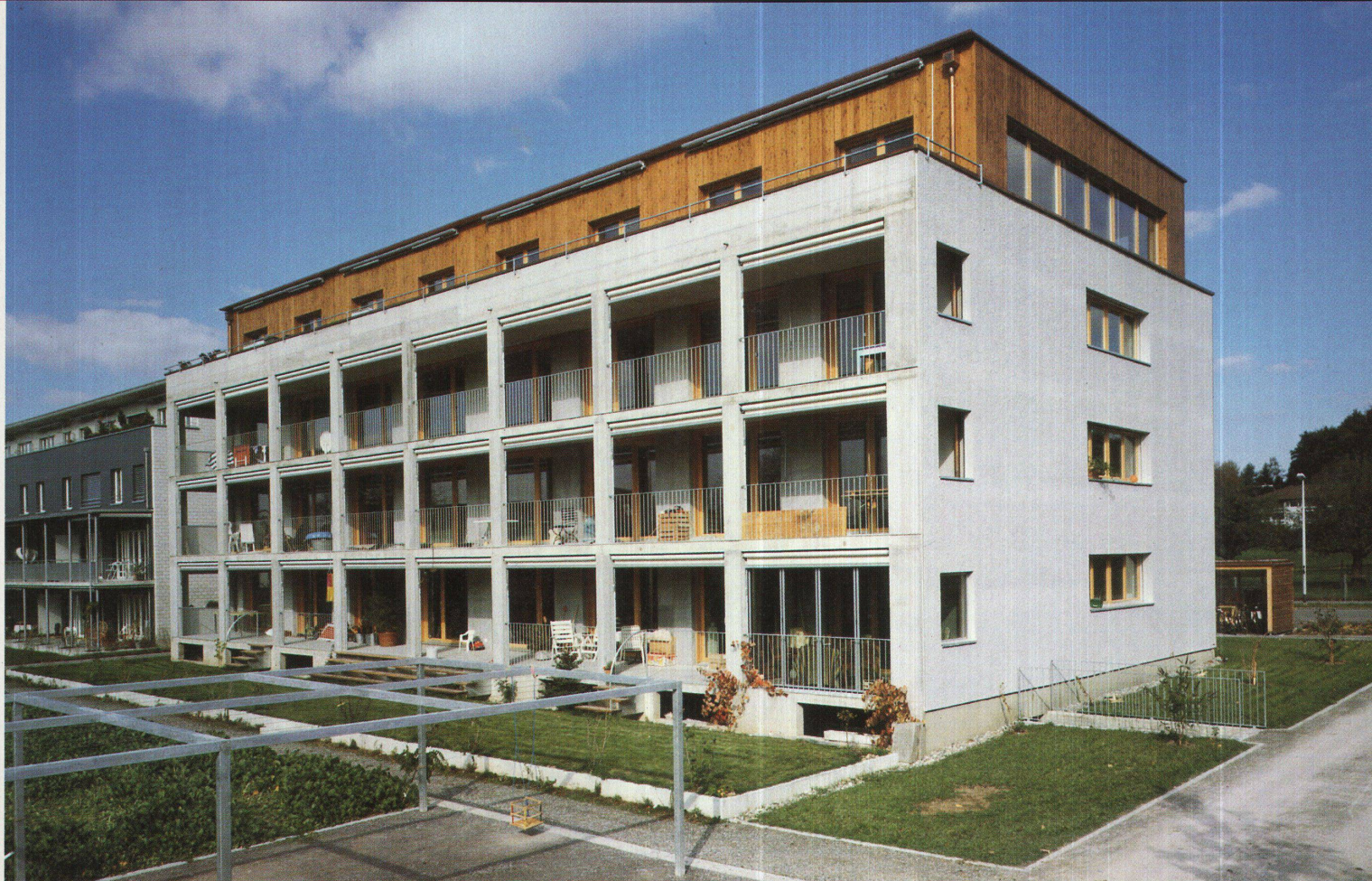
Die Südseite des Hauses mit vor die Fassade gestellter, selbsttragender Balkonkonstruktion. Der Aussenraum gehört zu allen Wohnungen
