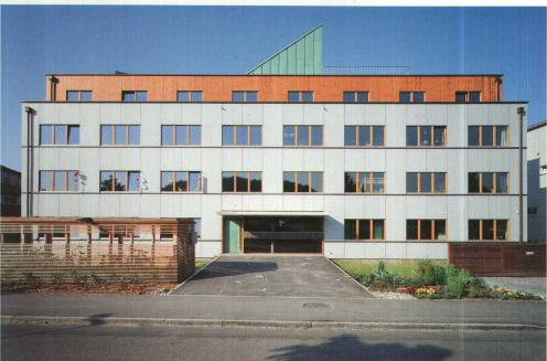
Die Südseite des Hauses mit vor die Fassade gestellter, selbsttragender Balkonkonstruktion. Der Aussenraum gehört zu allen Wohnungen
