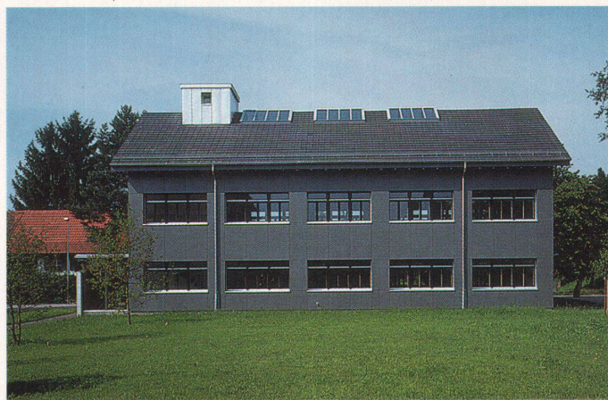
Die ehemalige Kartonfabrik. Die eingesetzten Oberlichter im Firstbereich beleuchten den zum Galeriegeschoss ausgebauten Estrich
