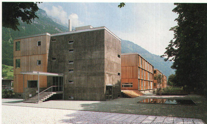
Westfassade und Erschließungsturm mit ebenerdigen Eingang
