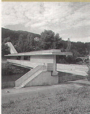
Ein Haus? Eine Brücke? Ein Steg mit 47 m Spannweite über die Mur bei Murau in der Steiermark
