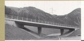
Eingebettet: Conzetts Erfolgsbrücke bei Sufers (links). Der Träger ist ein auf der Spitze stehendes Dreieck, in der Nut sind alle Werkleitungen versorgt (unten)
