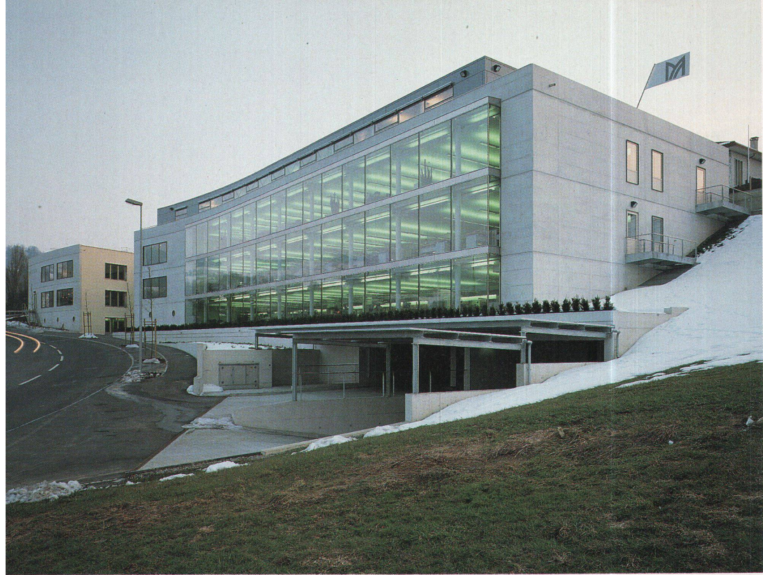
Hauptgebäude mit Glasfront, dahinter Hof und Kopfgebäude mit Bandfenstern und Bullaugen. Die Fassade ist selbsttragend, der Kern ein Skelettbau. Im Vordergrund die Einfahrt zur Tiefgarage
