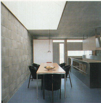
Unverputzte Zementsteinwände bei den Haustrennungen
