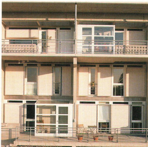
Fassade des Blocks A1 mit den von den Käufern gewünschten Unterschieden im Ausbau
