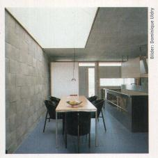
Unverputzte Zementsteinwände bei den Haustrennungen
