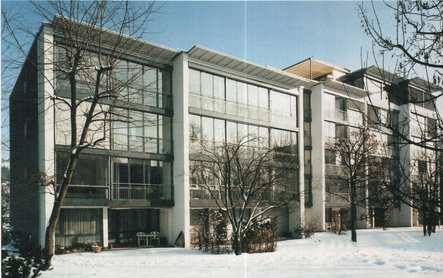
Der Wohnblock nach der Sanierung: Balkonseite
