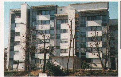
... und nach der Sanierung
