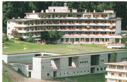
Die Felsentherme steht unterhalb eines Hotels aus den sechziger Jahren im Hang
