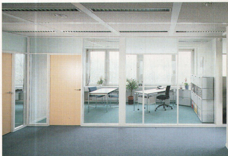
Die beweglichen Glaswände erfor-dern einen neuen Lichtschalter: Neben den Türen ist die Lichtschnur erkennbar
