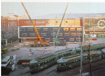
Für das Dienstleistungszentrum wurden vorfabrizierte Holzbauteile verwendet
