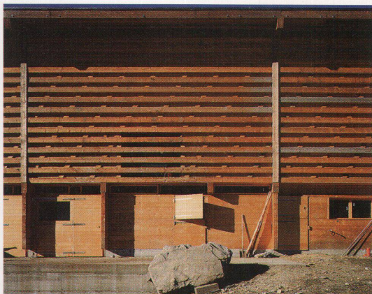
Die schrägen Latten an der Stallfassade sind nicht Zierde, sie dienen der Querversteifung
