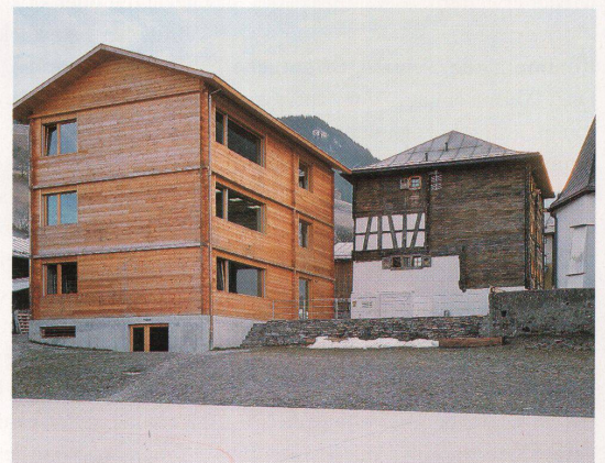
Das Schulhaus in Duvin: traditioneller Strickbau weiterentwickelt
