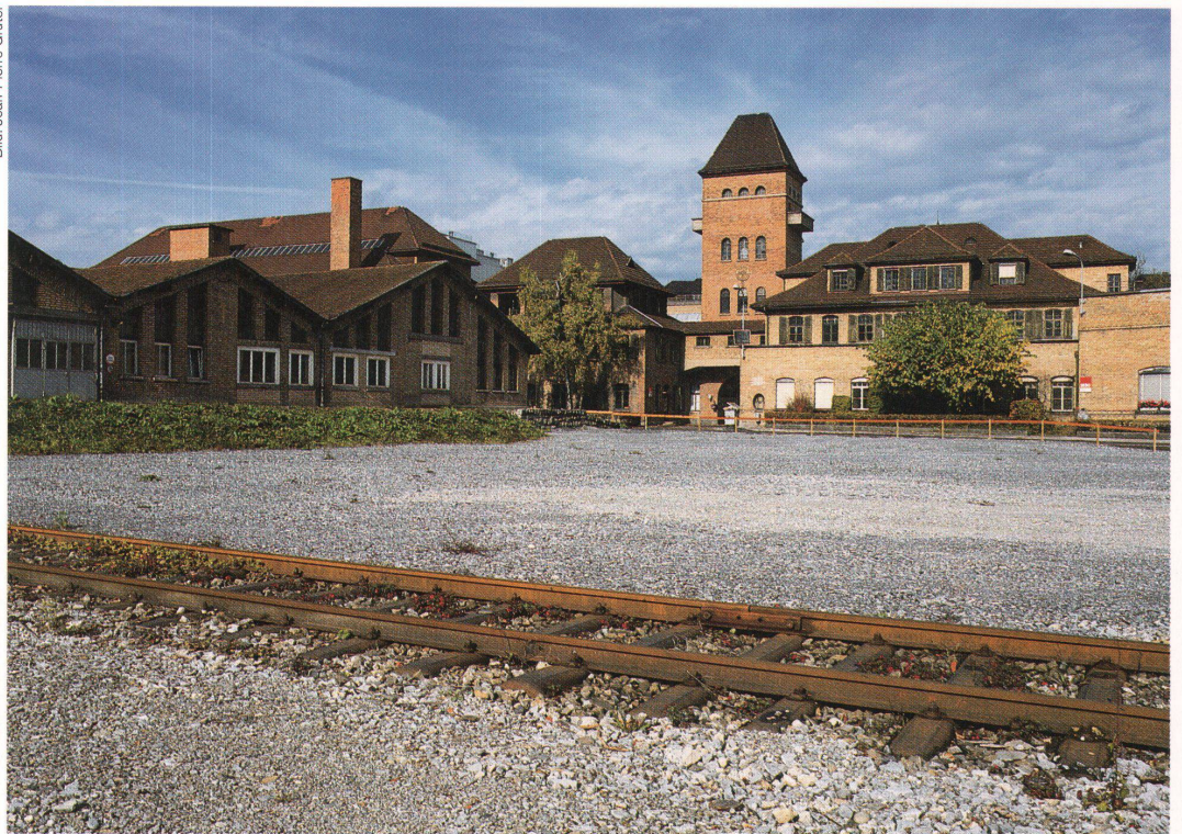
Das neue Zuhause für Sportkletterer im ehemaligen Eingangsgebäude Nr. 606
