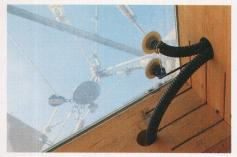
Das Luftkissendach wird aufgepumpt, und die Schläuche sorgen für den Druckausaleich
