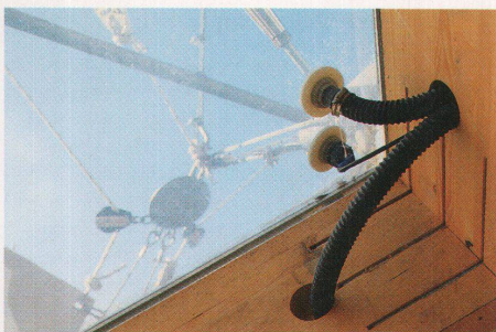
Das Luftkissendach wird aufgepumpt, und die Schläuche sorgen für den Druckausgleich
