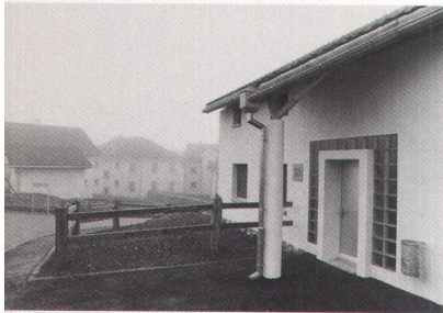
Der Eingang von Max Bär's Ferienhaus Nr. 10 an der Anwiesenstrasse
