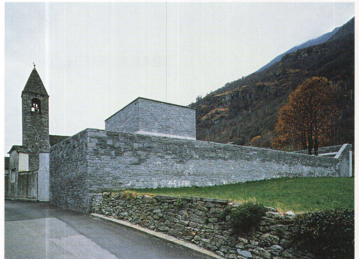
Die Mauer des neuen Friedhofs, darüber der Block der Aufbahrungskapelle
