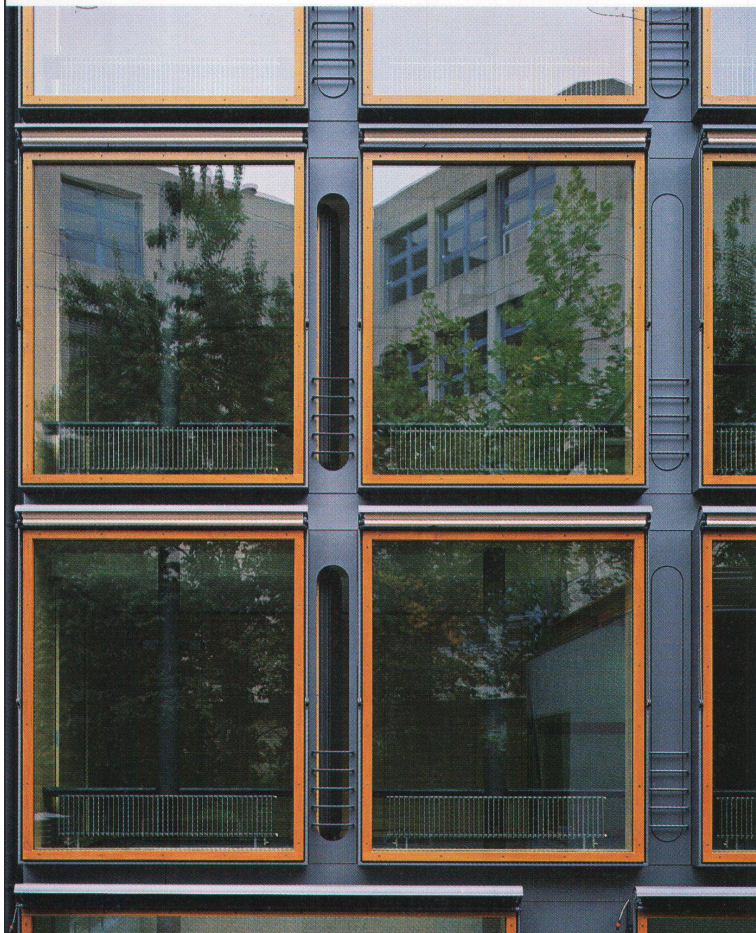
Die Hoffassade. Gerahmte Bilder mit ausgewogenen Waag- und Senkrechten
