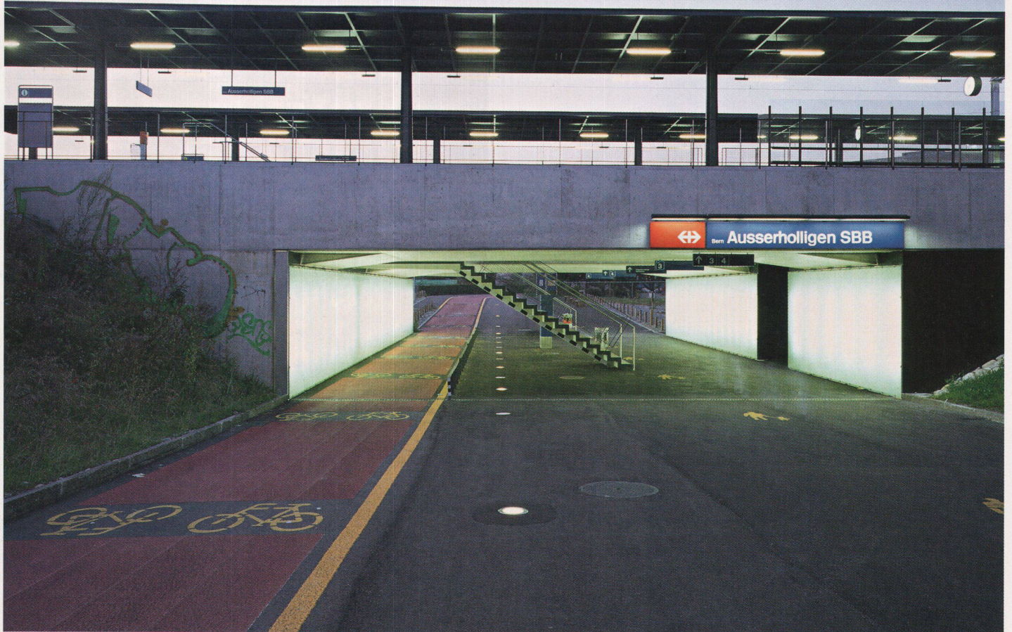
Wichtig für mehr Sicherheit: eine gläserne Lichtwand in der Unterführung und ein ausgeleuchtetes Perron
