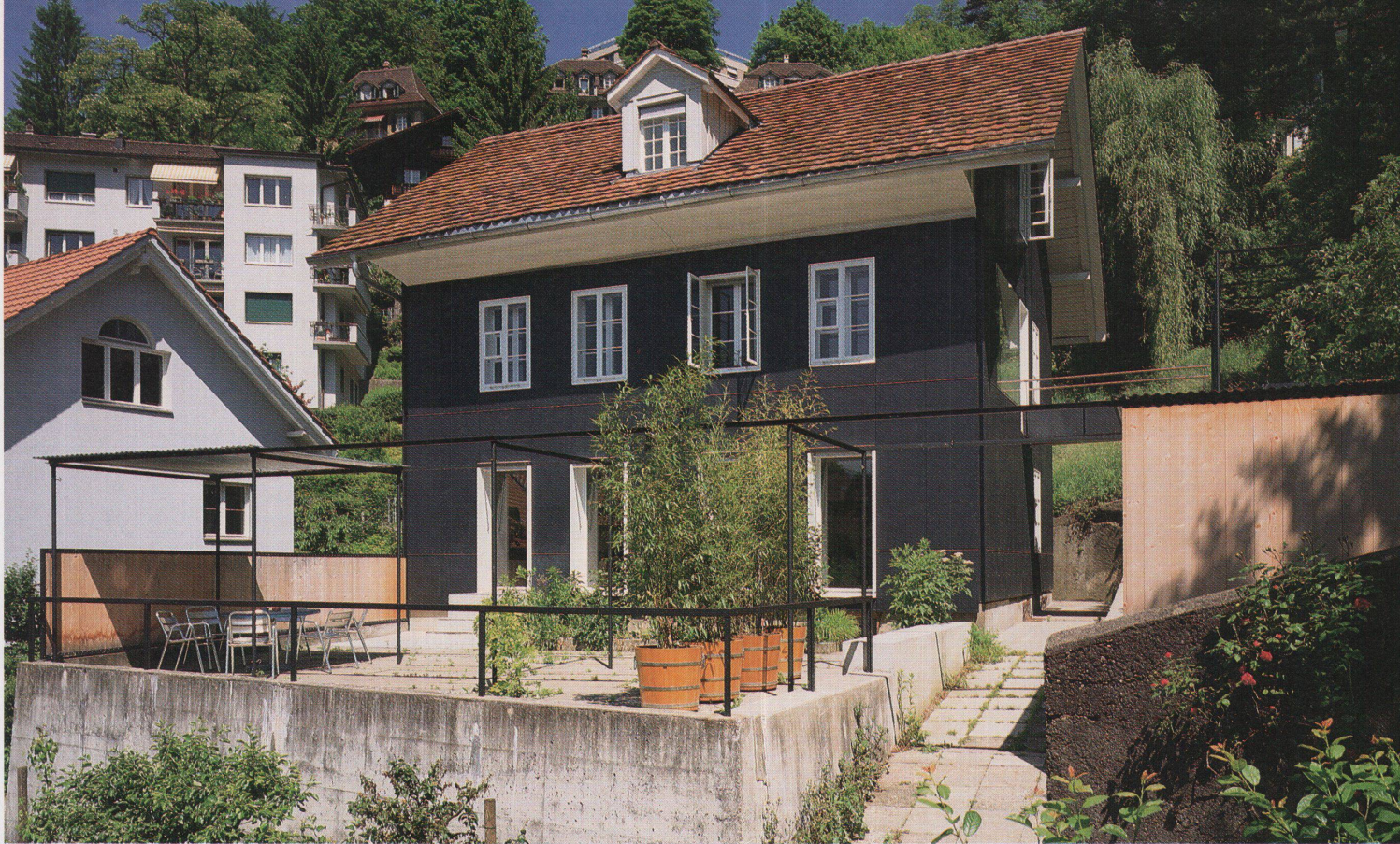
Eine Mansarde ist durch die bestehende Treppe von der Laube her erschlossen
