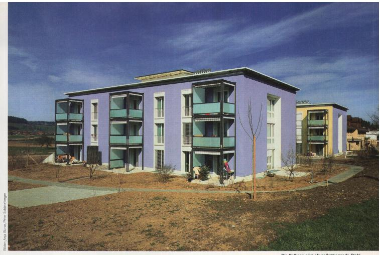
Die Balkone sind als selbsttragende Stahlkonstruktion vor die Fassade gestellt
