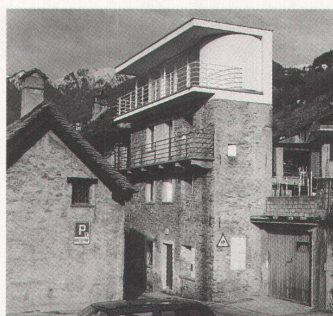
Das Turmhaus von Brenno Borradori in Gordola
