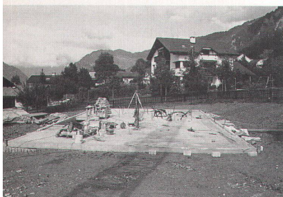
Auf dem Bauplatz in Scharans steht ein konventionelles Kellergeschoss für den Aufbau bereit
