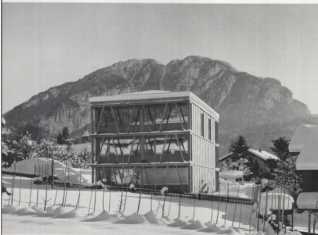
Der «Würfel» von Scharans. Die Streben im Bereich der dreistöckigen Veranda dienen der Aussteifung in Querrichtung
