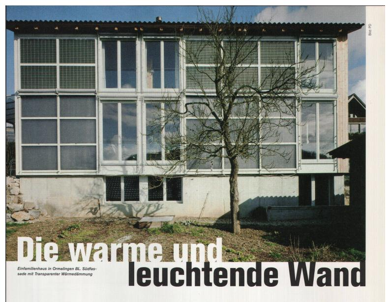
Durchscheinend und wärmedämmend, das schloss sich bisher aus. Mit der Transparenten Wärmedämmung ergeben sich neue technische und auch gestalterische Möglichkeiten. Ein Material erlaubt ein altes Thema neu: die leuchtende Wand.
