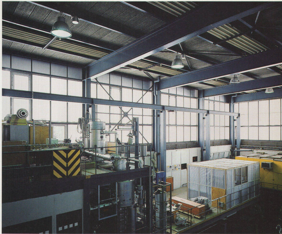
Werkhalle im Paul Scherrer-Institut in Villigen. Für die Sanierung der Fassade wurde TWD eingesetzt
