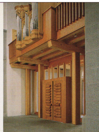
Über dem Eingang zum Mittelschiff liegt die Orgelempore auf Massivholzbalken
