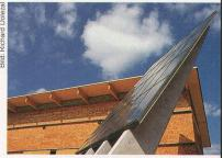
mel. Seine Fläche misst sechs mal zehn Meter. Er heizt das Warmwasser und dient zur Heutrocknung und der Gebäudeheizung. Die Sonnenenergie soll auf diese Weise rund 85 Prozent des Bedarfs decken, eine Holzschnitzelheizung liefert den Rest.
