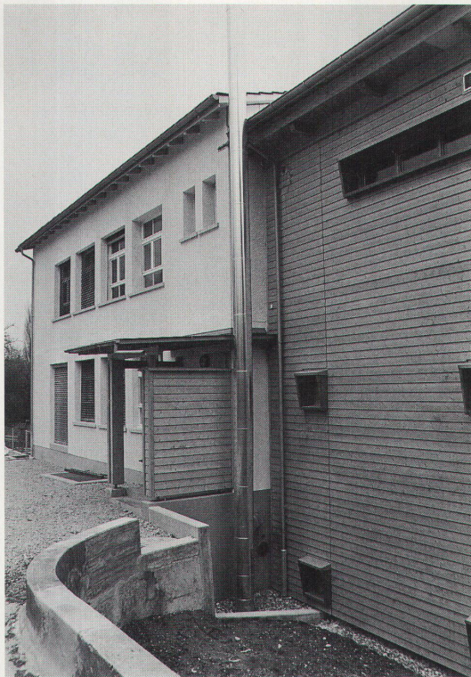
Alt und neu nebeneinander: Die alte Bau- substanz blieb unverändert, der Neubau ist in Elementbauweise entstanden
