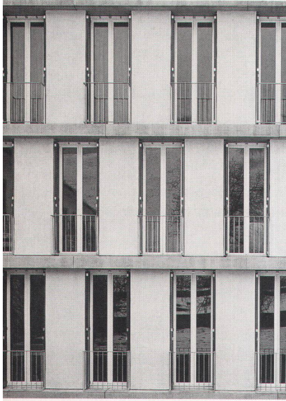
Die fortlaufenden Reihen der tragenden Wandplatten sind von Geschoss zu Geschoss gegeneinander versetzt
