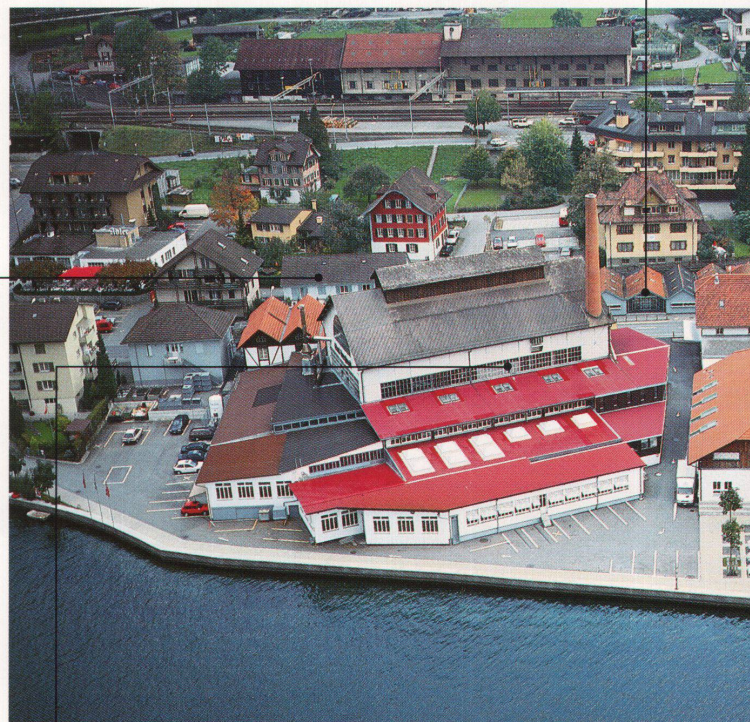
Luftbild der Anlage der Glasi Hergiswil
