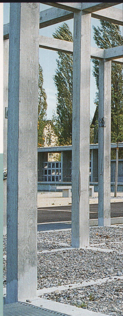
Die Urnenwände treten mit ihren Betonstützen aus der Wasserfläche heraus
